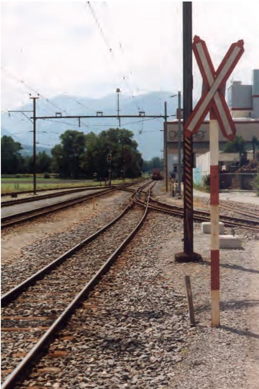
Die Station Untervaz verfügt über einige Werkanschlussgleise, die teilweise für eine Spurweite von 1000 mm und 1435 mm mit einem Dreischienengleis ausgestattet sind
